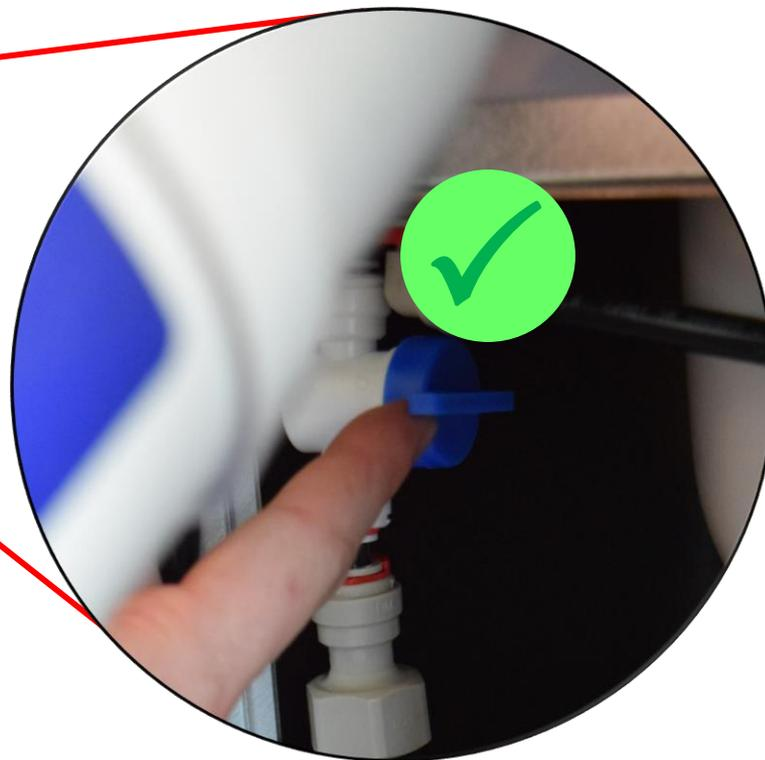
Aprire la maniglia di bloccaggio sulla testa del filtro.
